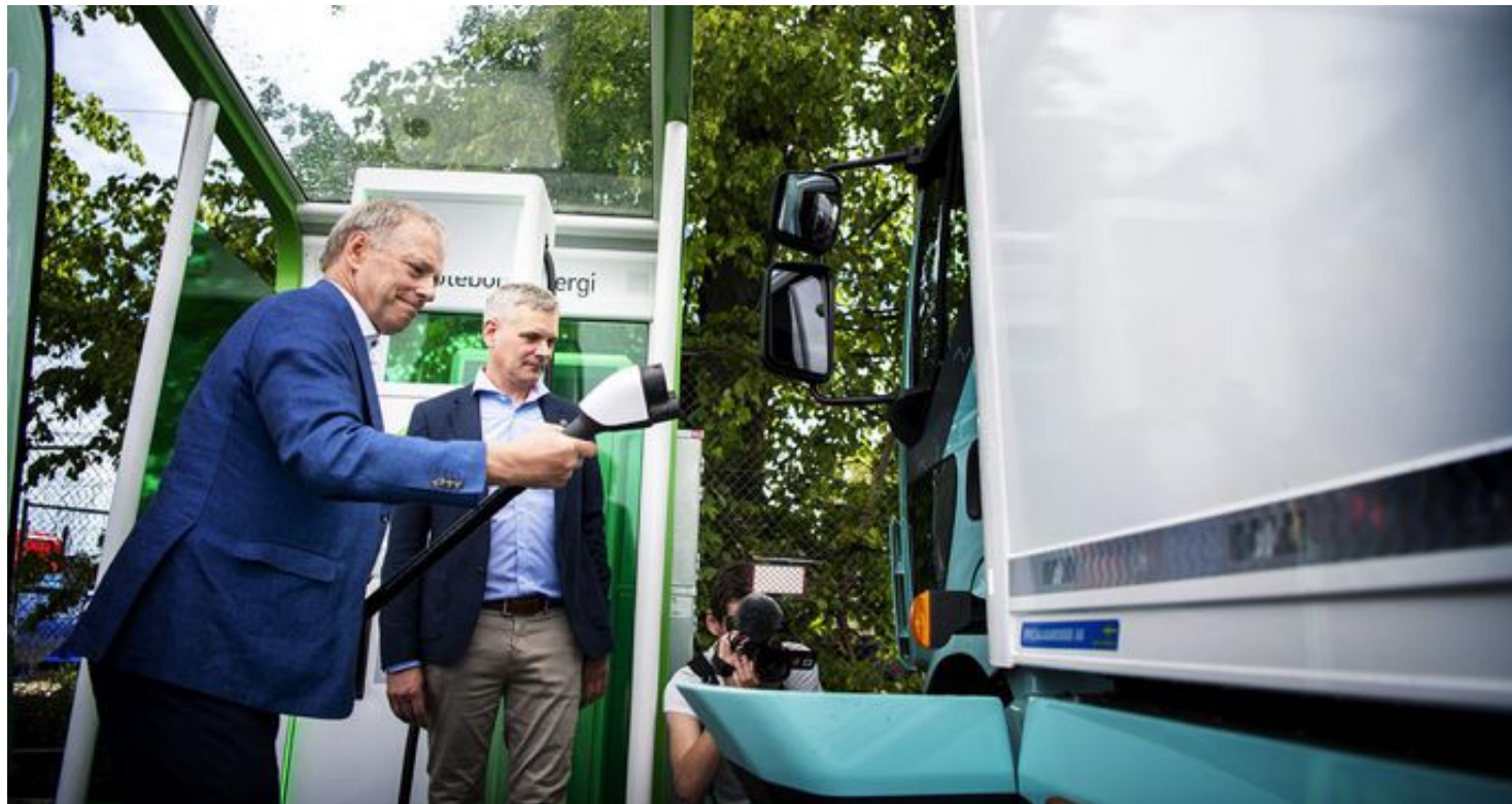
Göteborgs Energis nya laddstation är av en helt ny typ, anpassad för tung trafik som distributionslastbilar och renhållningsfordon. Alf Engqvist, vd för Göteborg Energi och Volvo Lastvagnars Sverige- och Stefan Strand var på plats vid invigningen. Bild: Anders Ylander
