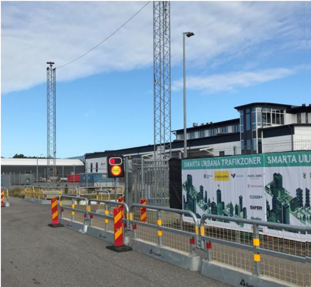
Varning för lastbil på väg in till byggarbetsplats
