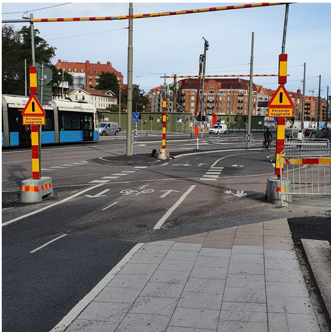
Figur 1. En obevakad cykelpassage och byggutfart vid Korsvägen, Göteborg
