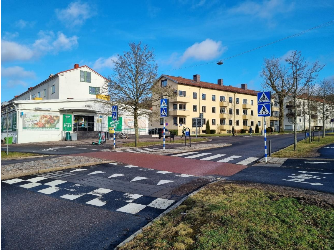
Figur 3. En cykelöverfart vid Delsjövägen i Göteborg. Här syns bl.a. vägmarkering M17 farthinder, vägmarkering M14 väjningslinje och M16 cykelöverfart
