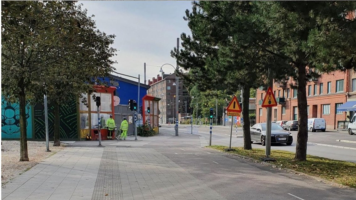
Figur 2. En bevakad cykelpassage och byggutfart vid Korsvägen, Göteborg. Här syns bl.a. vägmärkena A22 varning för flerfärgssignal och A40 varning för annan fara och tilläggstavlan T22 med texten byggtrafik.
